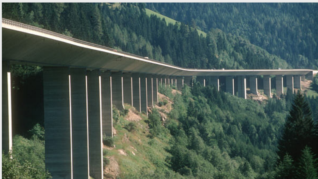
Снимка 6. Мост при Liesertal по пътя A10 http://bauwiki.tugraz.at/pub/Baulexikon/BrueckenInOesterreichC/Kremsbruecke.jpg
